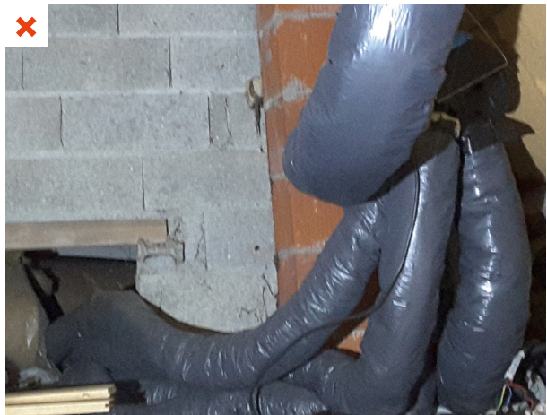
Les réseaux souples raccordés au caisson présentent tous un point bas, favorisant l'accumulation d'eau en cas de condensation. L'installation a été réalisée, dans ce cas, en un temps très court. ©AQC
