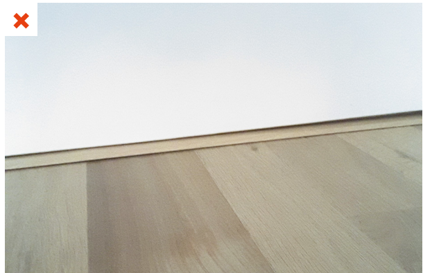
La sur-élévation du niveau du sol fini suite à la pose du parquet et de la barre de seuil entraîne la disparition du passage de transit initialement présent. ©AQC
