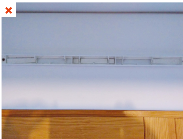
Sur ce coffre de volet roulant, une entrée d'air a été posée mais la mortaise n'a pas été réalisée. ©AQC
