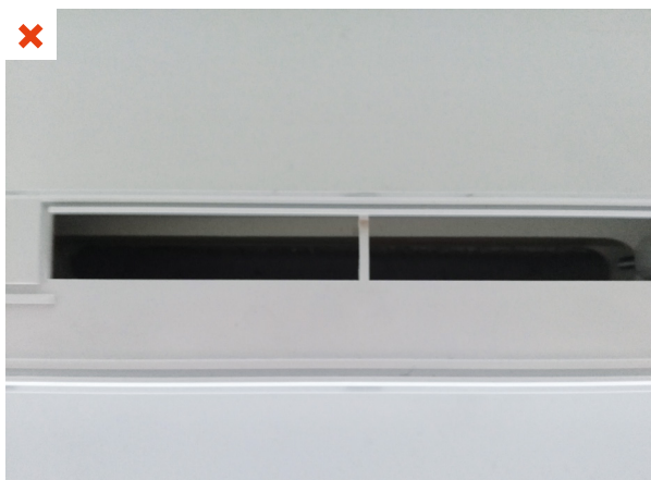
La mortaise a été réalisée mais le module d'entrée d'air n'a pas été installé. Ceci ne permet pas de réguler les débits d'air entrants. ©AQC
