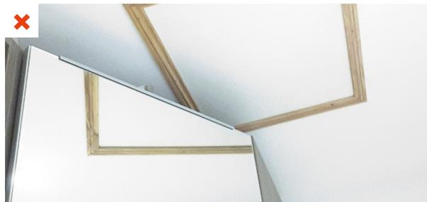
Dans ce logement, un dressing a été installé par l'habitant sous la trappe d'accès au caisson d'extraction. Celle-ci étant vissée, le dressing empêche l'accès à l'une des vis et la dépose de la trappe. ©AQC
