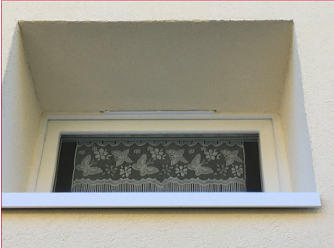
Obturation partielle de l'entrée d'air de la menuiserie par l'ITE
